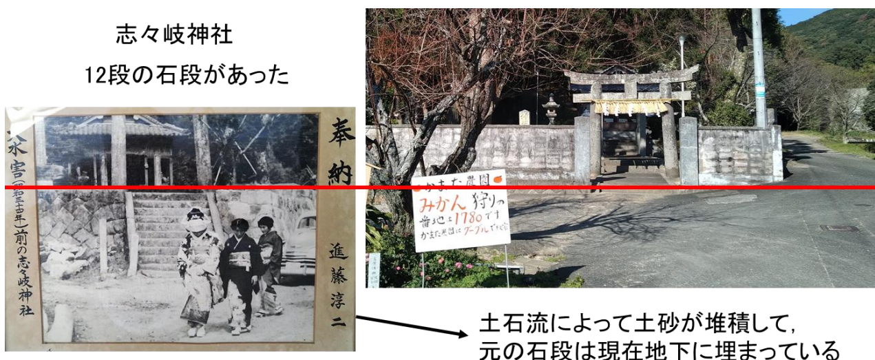
図 9 土砂に埋まった志々岐神社の石段（左の写真：神社内に奉納された災害前の写真）
