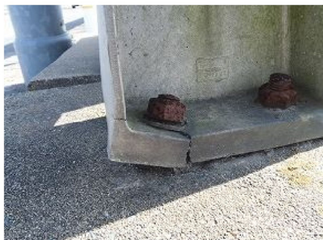
鋼材の亀裂
