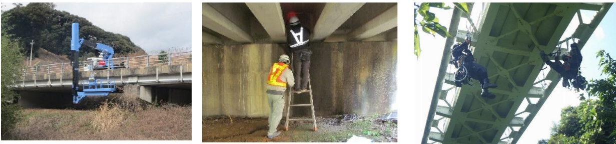
写 3-1 点検状況（左より 橋梁点検車・梯子・ロープアクセス）
