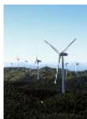
風力発電(三重県・新青山高原風力発電所)
