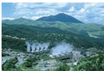
地熱発電(九州電力・八丁原地熱発電所)
