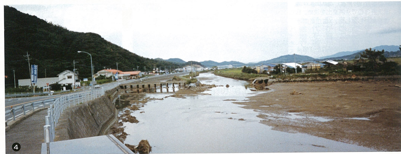
写真③④ 平成3年（1991）9月14日、福岡地方に上陸した台風17号の被害状況。二丈町で瞬間最大風速48m/s、雨量110mm/日を記録。床下浸水130戸、公共土木施設損壊94カ所などの被害がありました。写真③は佐波、写真④は松末（羅漢橋）の被害状況です。
