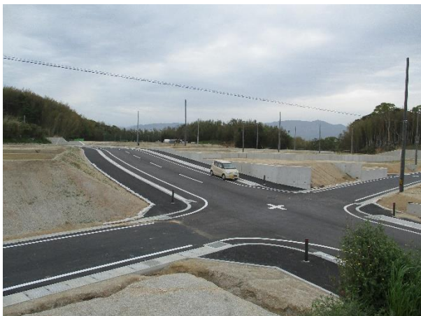
宅地造成状況（令和5年4月時点）
