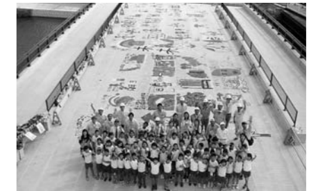
旧赤坂橋は、当時の新聞により大正10(1921)年に架設され、約90年前に造られたことが分かっています。地元でも平成14年度に赤坂橋架け替え推進委員会を設置し、架け替え工事に協力されています。
