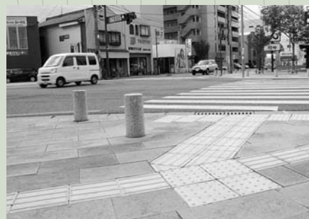
整備された道路の点字ブロック
