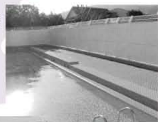
改修された深江小学校のプール
