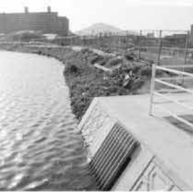
伏龍池の洪水調整ゲート
