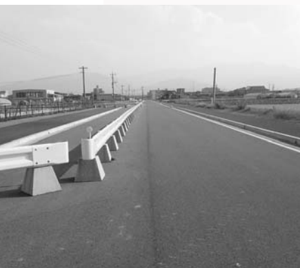
建設中の中央ルート
