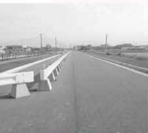
建設中の中央ルート
