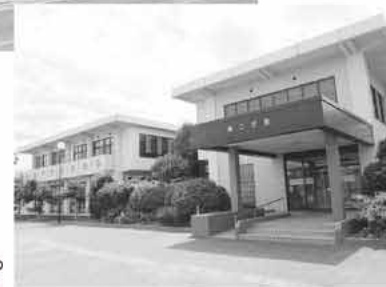
志摩館が入る予定の志摩支所第二庁舎
