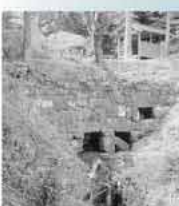
切り石で造られた北水門
