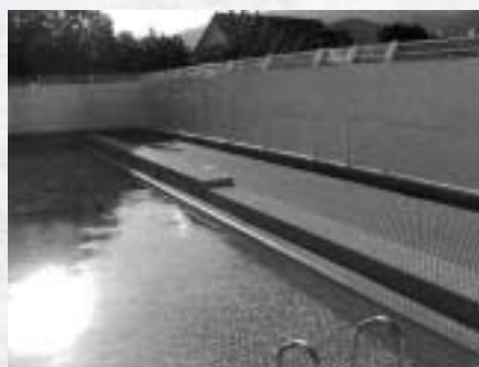
改修した深江小学校のプール
