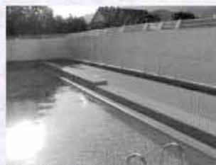
改修した深江小学校のプール
