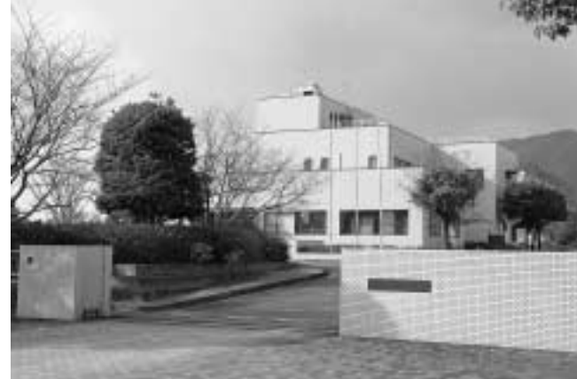
下水道管理センター
