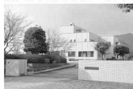
下水管理センター
