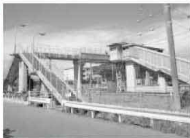
JR加布里駅の渡線橋
