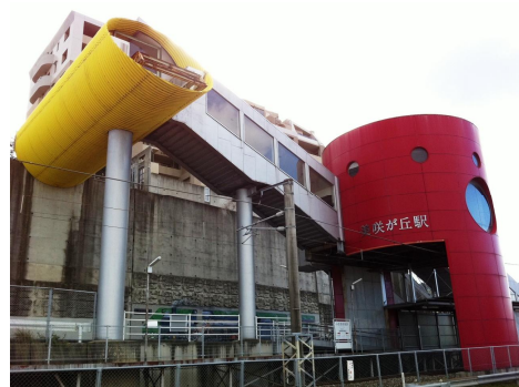
■ 図 16 エレベーターがない美咲が丘駅
