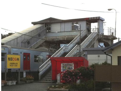
■ 図 36 エレベーターがない加布里駅
