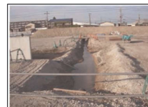
素掘り側溝設置例
