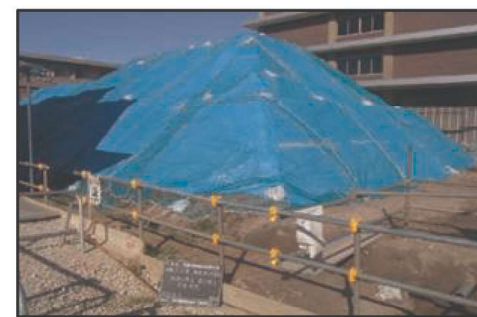
仮置き土の養生例
