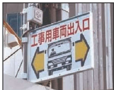
工事車両出入り口標識
