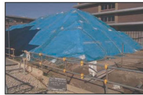
仮置き土の養生例
