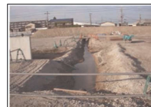
素掘り側溝設置例
