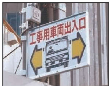
工事車両出入り口標識
