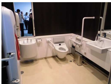
多目的トイレ（山鹿市）
