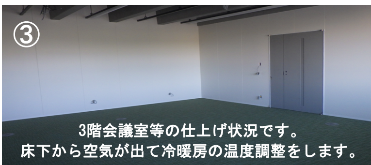
3階執務室の仕上げ状況です。 床下から空気が出て冷暖房の温度調整をします。
