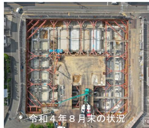
・基礎鉄筋を組み立てた後、型枠を入れてコンクリートを流し込みます。30m以上のブームを伸ばすことのできるコンクリートポンプ車を利用して作業します。この作業は、基礎の品質を決定する重要なポイントになります。
