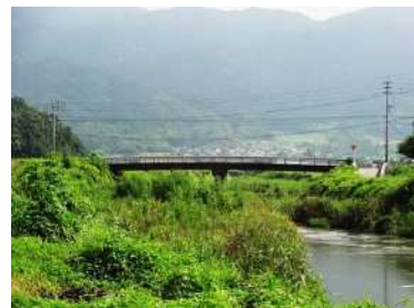
現在の畝詰橋
