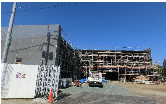
建設中の前原南コミュニティセンター
