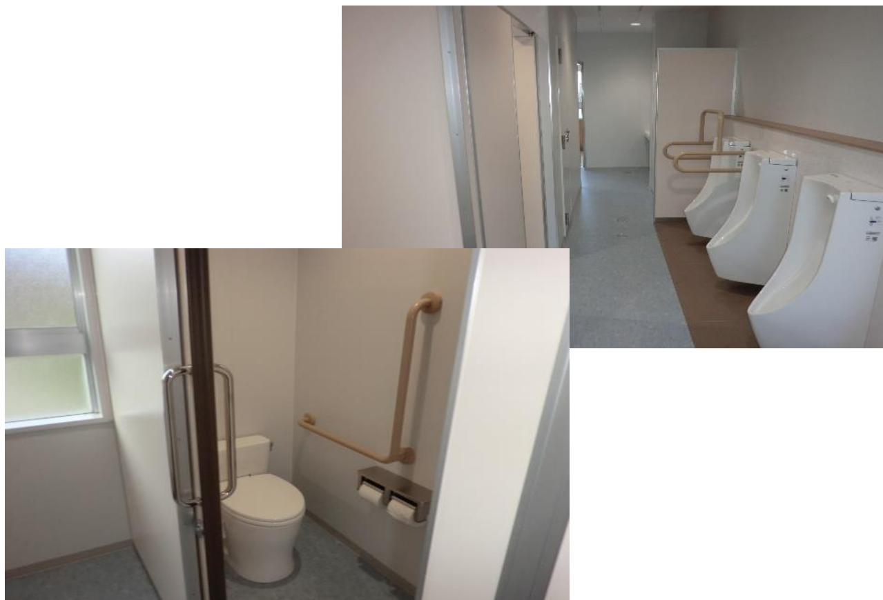
【改修後のトイレ（加布里小学校）】
