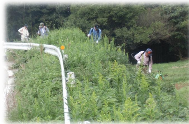
法面の草刈り作業。
