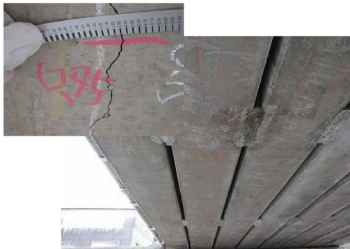
コンクリートのひびわれ
