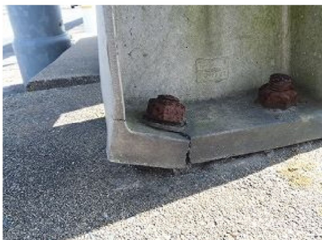
鋼材の亀裂
