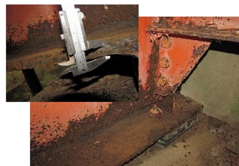
塗装の劣化及び鋼材腐食
