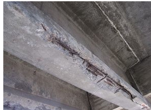
コンクリートの剥落
