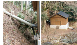
〈取水口・導水管・発電所土木工事〉 蔵持工業 (糸島市)
