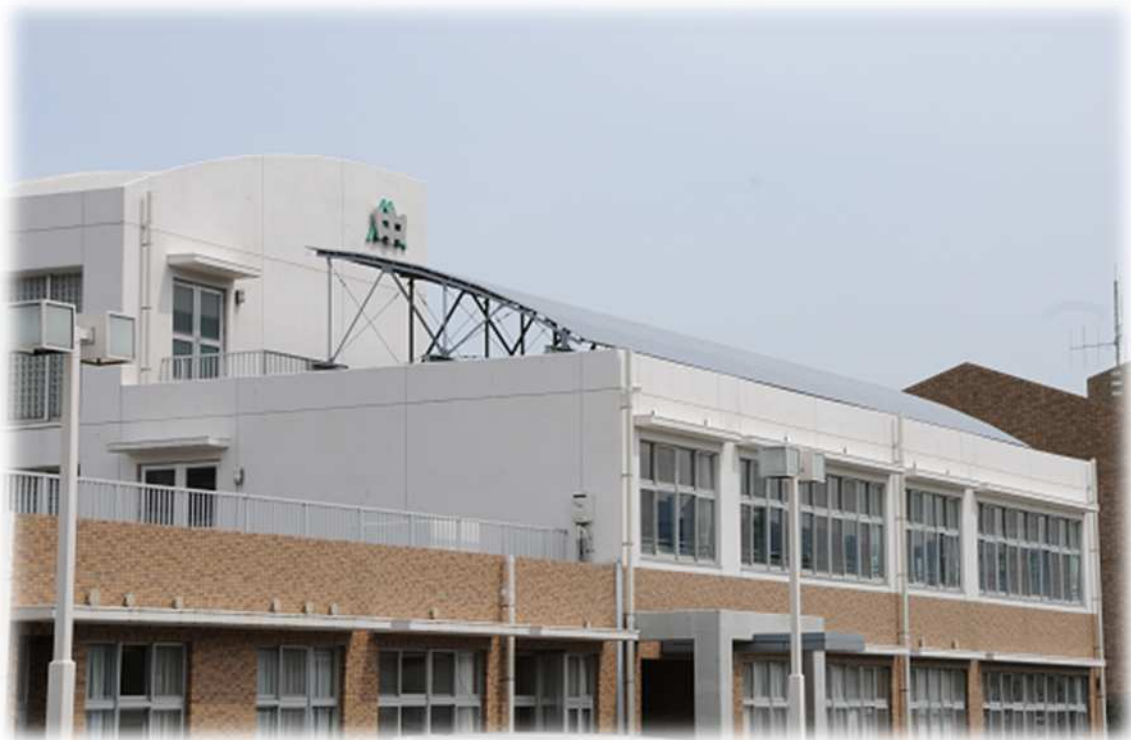
二丈中学校の太陽光発電
