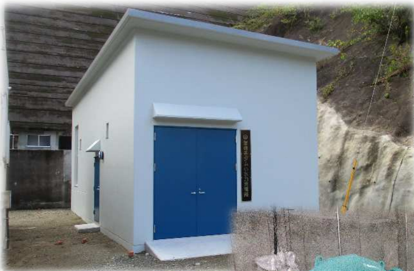
瑞梅寺ダム小水力発電所
