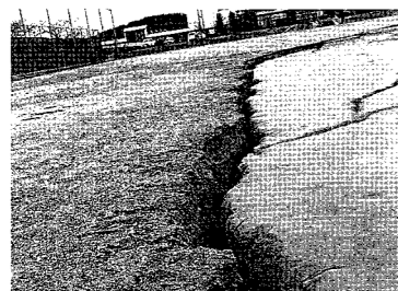
図55 福岡県西方沖地震による被害 志摩中グラウンド（平成17年）
