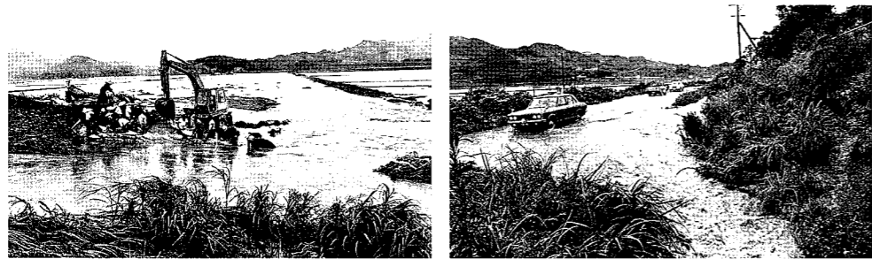
図53 桜井川堤防の応急工事（昭和47年）
