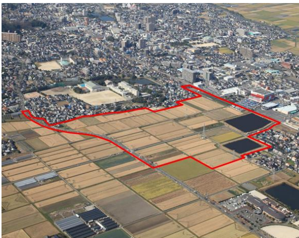
着工前（平成 24 年 10 月）
