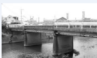
車の交通量が多い久保田橋
