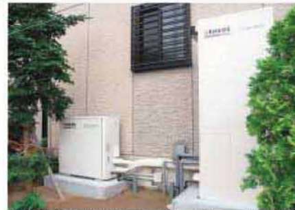
実証実験に使われた燃料電池システム1号機。水素タウンの150世帯に取り付けられている
