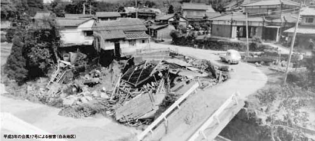
平成3年の台風17号による被害(白糸地区)
