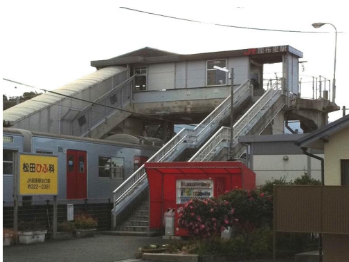
■図 36 エレベーターがない加布里駅
