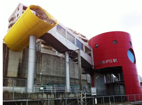
■図 16 エレベーターがない美咲が丘駅
