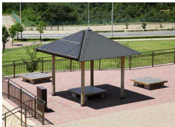
図 4 - 2 パーゴラ（東屋）を利用した太陽光発電パネル設置のイメージ
