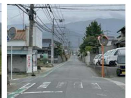
曾根幹線 (北側から)
