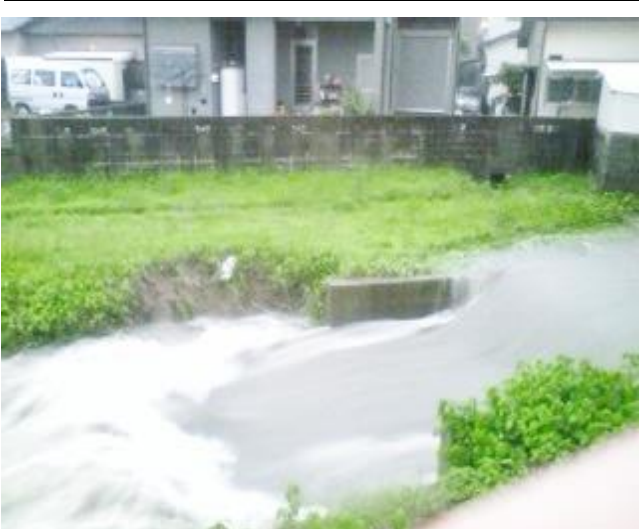
水門の影響で水面に段差発生！
